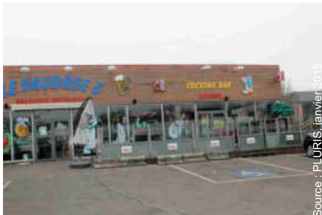
7. Bâtiment du Vaudrée
